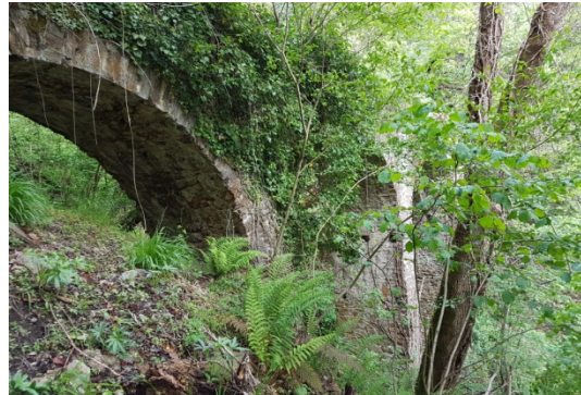
Imatge 20. Estat Actual obra de fàbrica (tres ulls).
