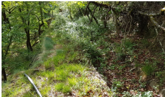
Imatge 10. Estat Actual canal.
