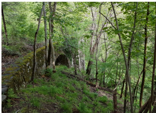
Imatge 17. Estat Actual obra de fàbrica (tres ulls).
