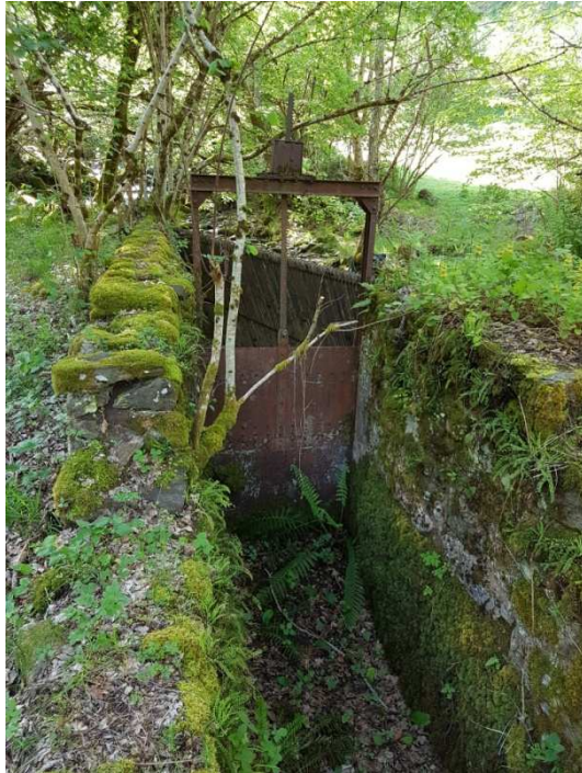
Imatge 07. Estat Actual comporta/canal captació aigües avall.
