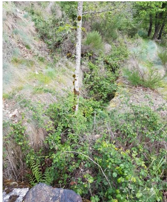
Imatge 12. Estat Actual canal.
