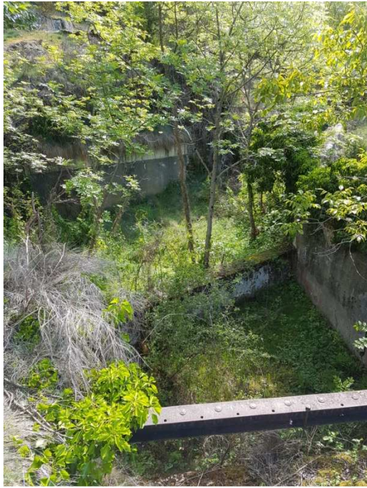
Imatge 25. Estat Actual càmera de carga, muret interior abans de la comporta i de la canonada forçada.
