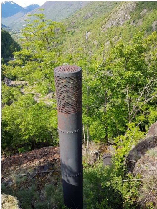
Imatge 27. Estat Actual xemeneia d'equilibri i canonada forçada.
