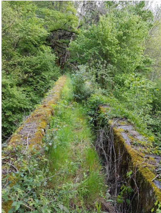
Imatge 19. Estat Actual obra de fàbrica (tres ulls).
