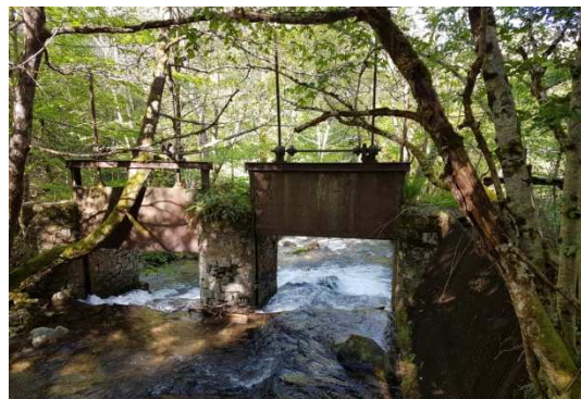
Imatge 06. Estat Actual de la captació aigües amunt.
