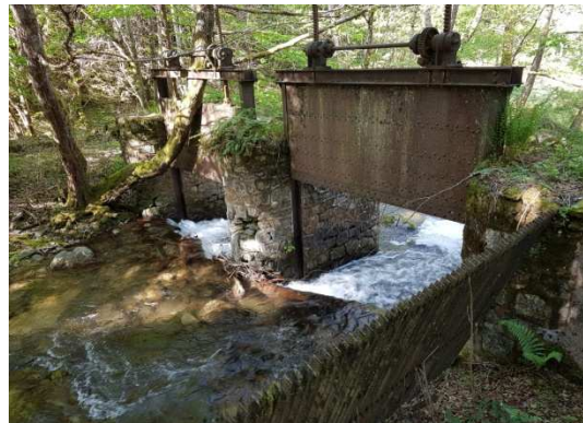
Imatge 04. Estat Actual reixa captació.
