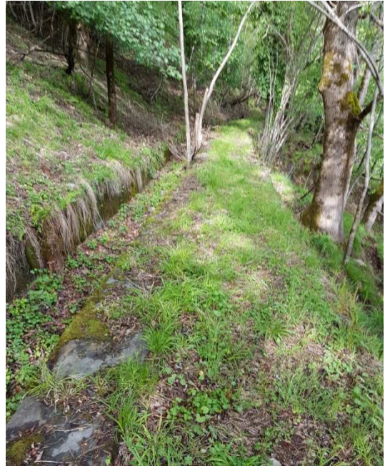
Imatge 14. Estat Actual canal. Tram captació a Naviàs.
