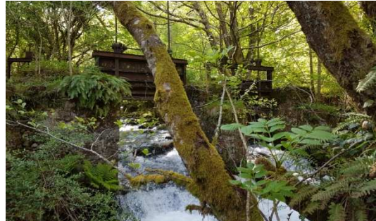
Imatge 08. Estat Actual captació aigües avall.
