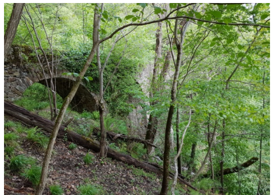
Imatge 18. Estat Actual obra de fàbrica (tres ulls).
