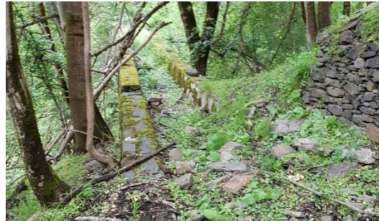
Imatge 21. Estat Actual obra de fàbrica (tres ulls).
