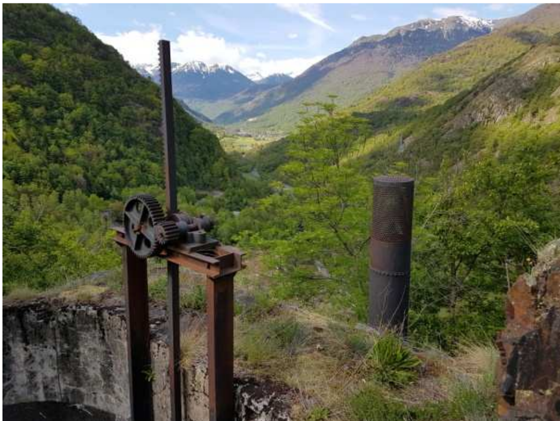
Imatge 29. Vista des de la càmera de carga, zona de la comporta, canonada forçada i xemeneia d'equilibri.
